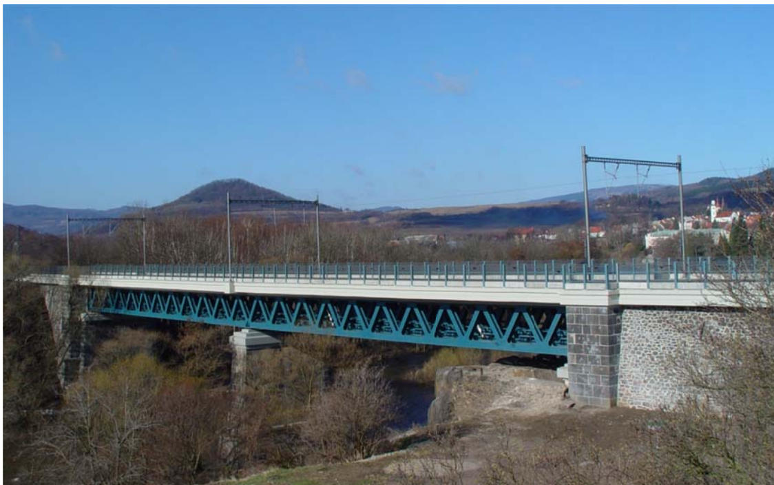
Klášterec nad Ohří (nový stav) – spřažená konstrukce s železobetonovou mostovkou s kolejovým ložem
