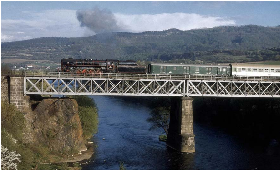
Kláštorec nad Ohří (starý stav) – příhradová konstrukce s násobnou soustavou a prvkovou mostovkou
