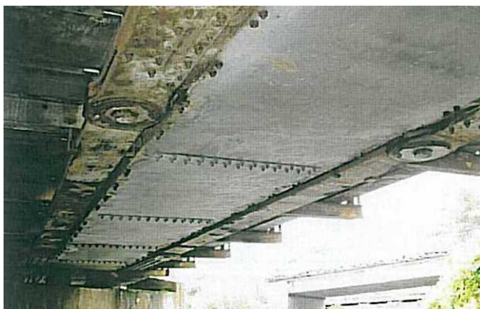
Obr. 3 Pohled na předpínací táhla a dolní pásnice konstrukce z roku 1973, resp. 1986
