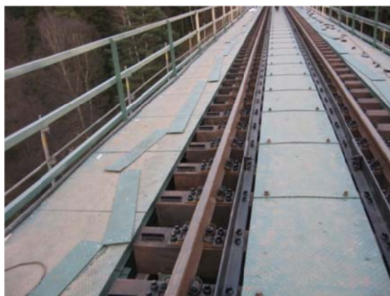
Obr. 9 Po montáži koleje, PÚ a podlah
