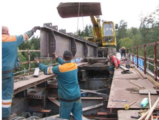
Obr. 11 Osazování podélníků
