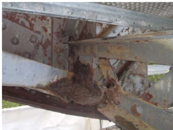
Obr. 3 Dolní příčné ztužení
