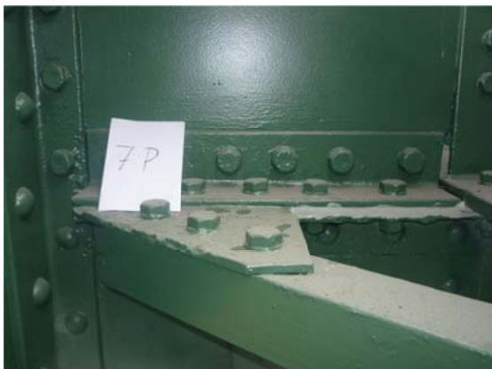
Obr. 6 Přípoj po opravě
