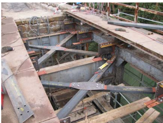
Obr. 10 Pole před osazením podélníků
