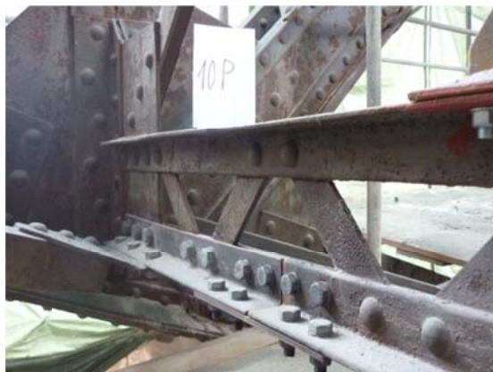
Obr. 7 Dolní příčné ztužení po opravě
