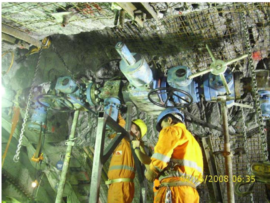
Obr. 9 Protivýronové zařízení (blowout preventer) na tunelovacím stroji – tlaková zkouška do 200 bar Na Gotthardském tunelu byla tato zařízení nasazena s cílem odolat tlaku vody do 200 bar. Tento tunel, který je se svými 57 km nejdelším tunelem na světě, bude uveden do provozu koncem roku 2017.
