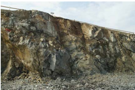
Obr. 2 Západní svahu v oblasti elevací
