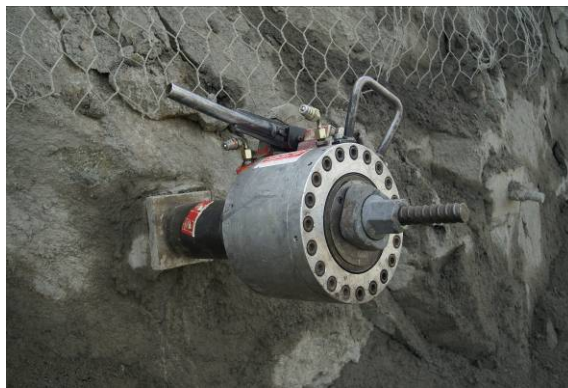
Obr. 16 Zkoušení celozávitových předpjatých kotev
