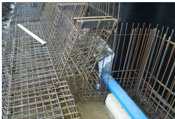
Obr. 20 Boční drenáž po vyztužení patek
