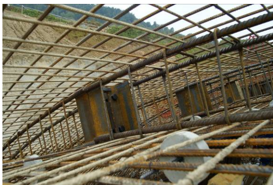
Obr. 21 Stykování rámu samonosné výztuže
