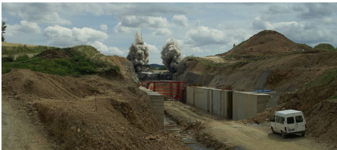
Obr. 13 Betonové klíny pro rozepření klenby hloubeného tunelu o boky stavební jámy
