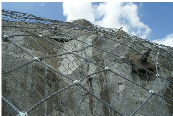
Obr. 15 Stabilizace svahu HEA panely
