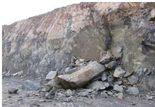
Obr. 7 Rozpad horniny podél ploch nespojitosti
