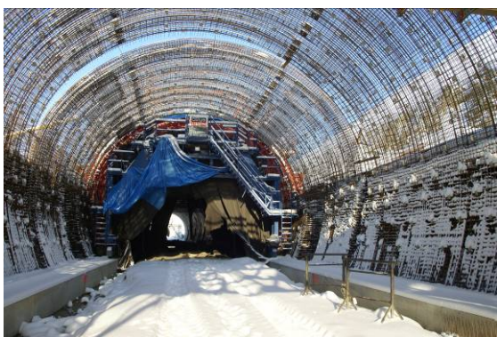
Obr. 19 Samonosná výztuž ostění
