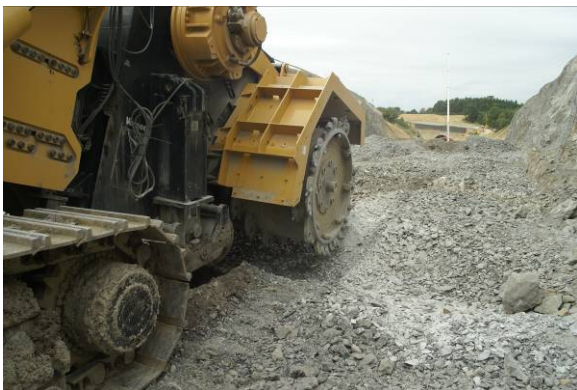
Obr. 17 Nasazení skalní frézy u vjezdového portálu
