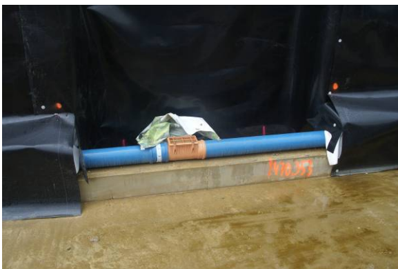
Obr. 19 Boční drenáž před vyztužením patek
