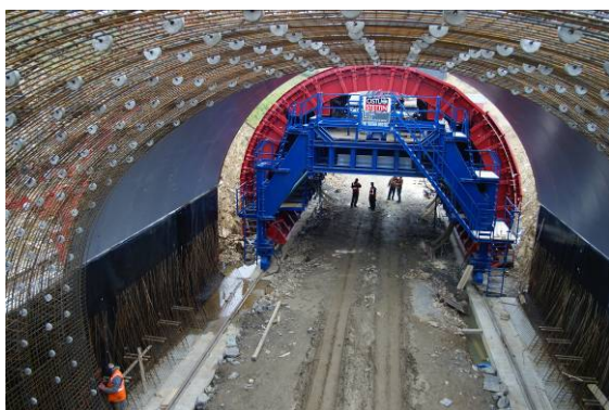
Obr. 9 Bednicí vůz s děleným čelem pro těsnící pás
