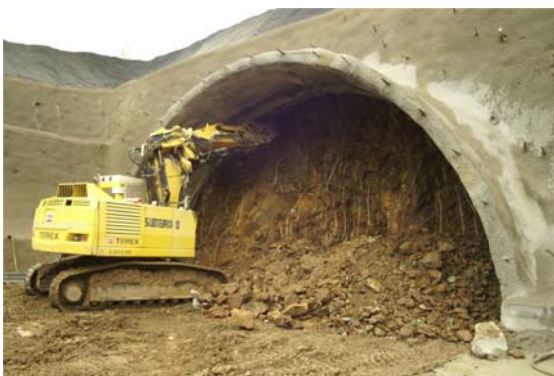
Obr. 2 Výjezdový portál Olbramovického tunelu – hornina se úlomkovitě rozpadá, čelba je stabilní
