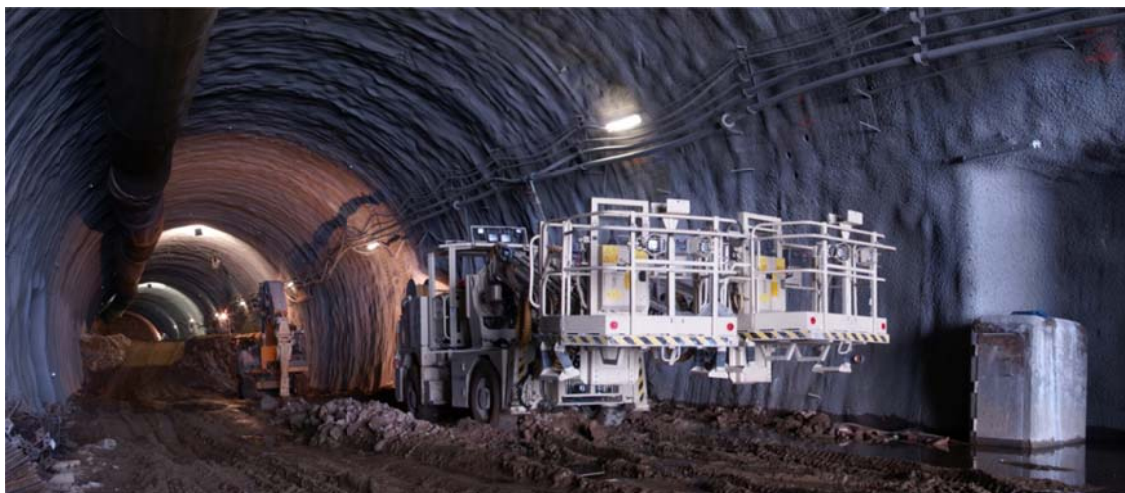
Obr. 4 Primární ostění Olbramovického tunelu, členění výrubu, vlevo rampa do kaloty
