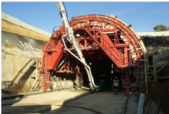
Obr. 5 Bednicí vůz hloubených tunel se speciálním čílkem pro vložení těsnícího pásu
