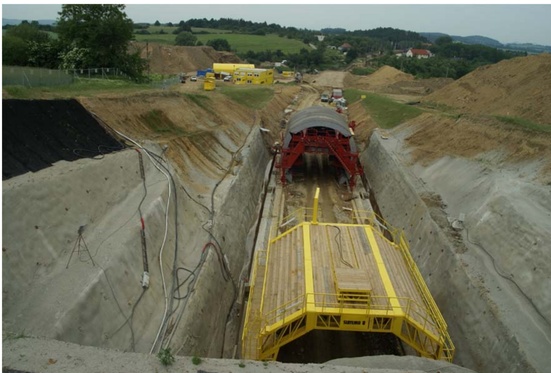
Obr. 1 Svahovaná stavení jáma Olbramovického tunelu – výjezdový portál
