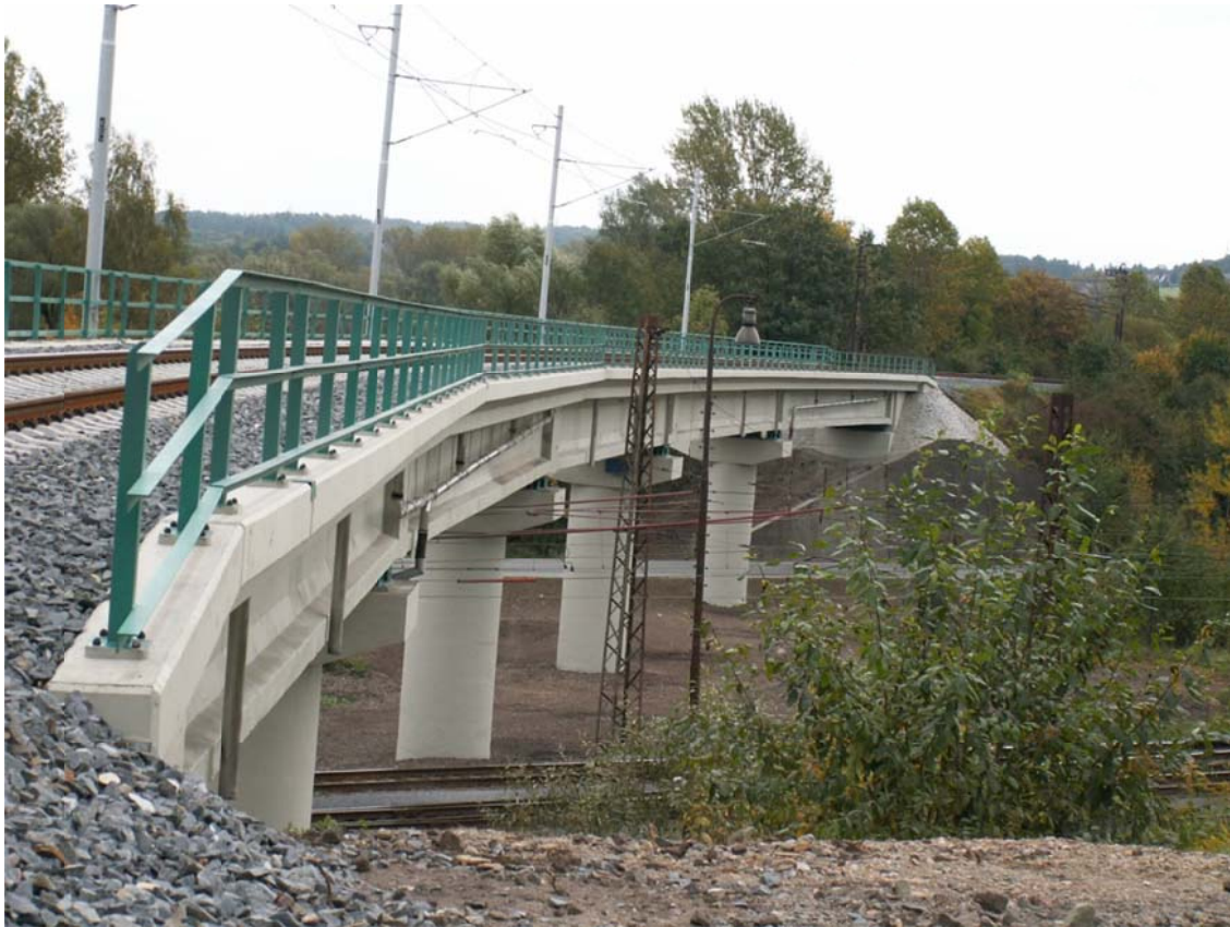
Obr. 1 Nový stav mostu
