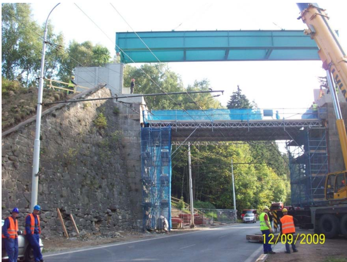
Obr. 9 Montáž nové konstrukce
