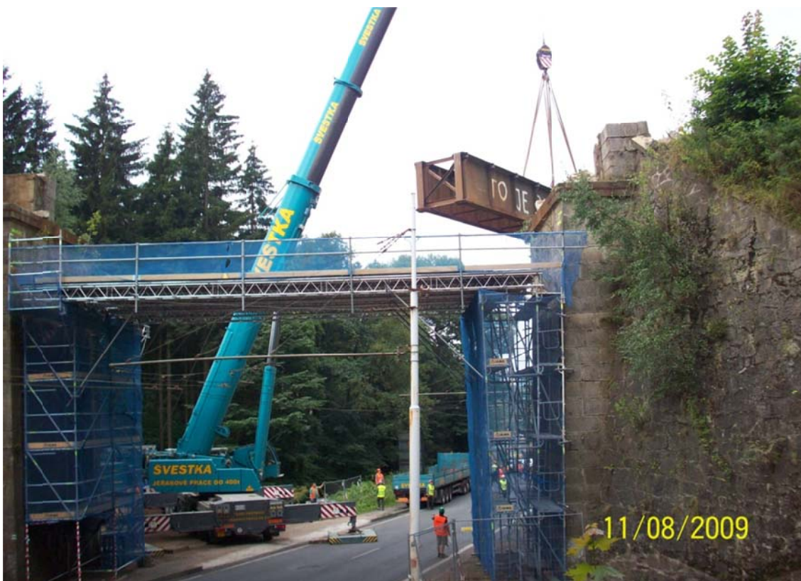
Obr. 6 Demontáž původní konstrukce
