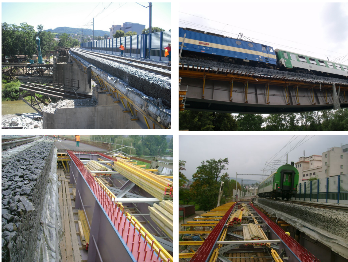
Obr. 4 Pokračující rekonstrukce mostu
