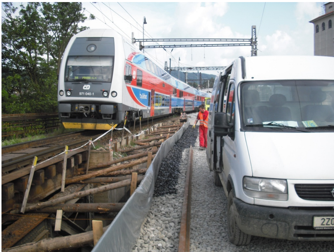
Obr. 2 První etapa stabilizace
