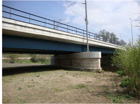
Obr. 5 Nová NK nad pilířem
