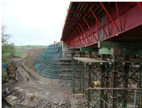
Obr. 9 Těleso z armovaných zemín, opěra O2 a NK před betonáží
