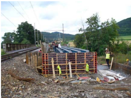
Obr. 1 Výstavba mostu v koleji č. 1
