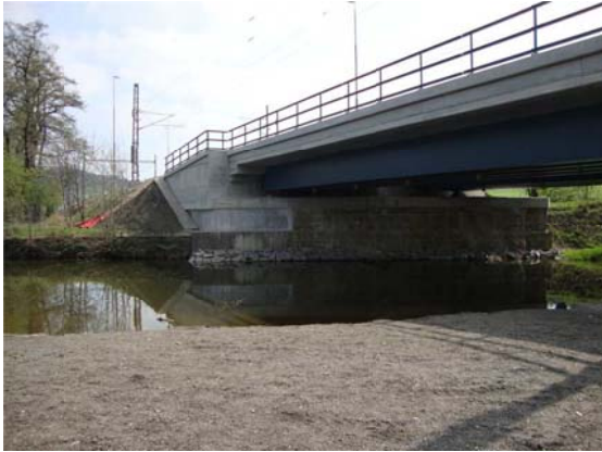
Obr. 4 Nová NK, opěra s novým ÚP a křídlem
