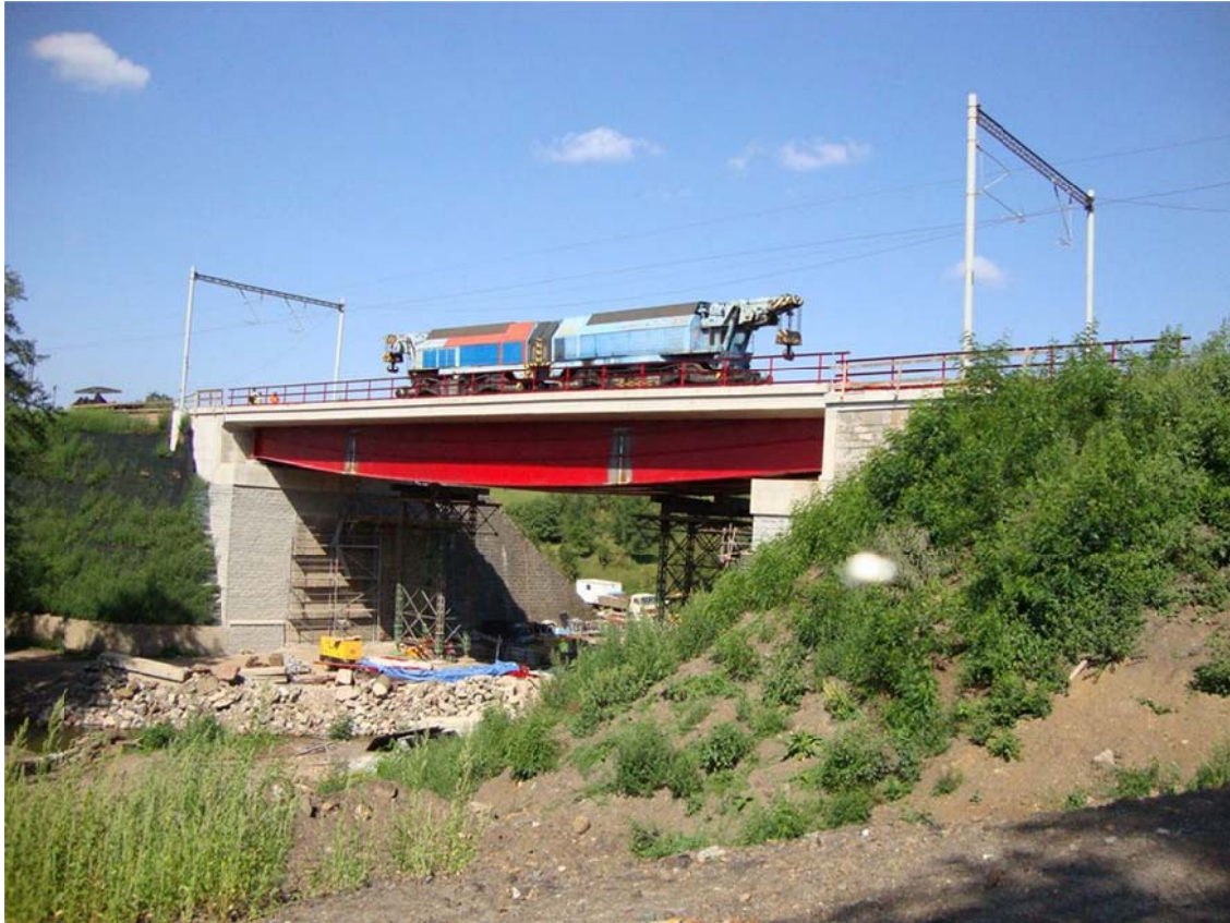
Obr. 10 Zatěžovací zkouška 2. NK
