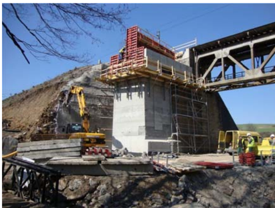
Obr. 8 Betonáž opěry O2, pažení zemního tělesa
