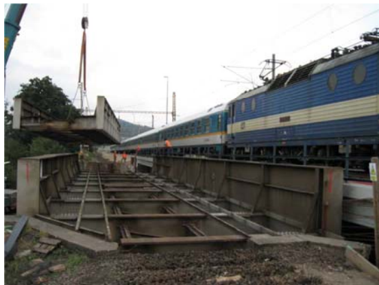
Obr. 2 Snášení původních OK v koleji č. 2
