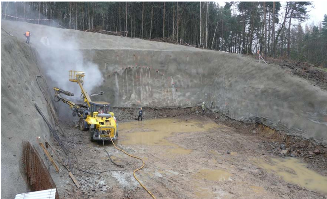
Obr. 1 Pohled na jižní vjezdový portál
