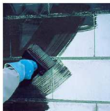
6. Před nanesením bitumenové stěrky se musí povrch napenetrovat se Sopro KellerDicht Grundierung.
