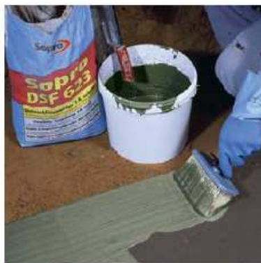
1. Vodorovná uzávěra se Sopro DichtSchlämme Flex 1-K, 1-K schnell nebo 2-K se provádí lehce na předem navlhčený podklad..
