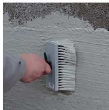
4. Aby nebyla hydroizolační stěrka poškozena prosakující vlhkostí zevnitř, nanáší se na suterénní zdivo a sokl mezivrstva Sopro DichtSchlämme Flex.
