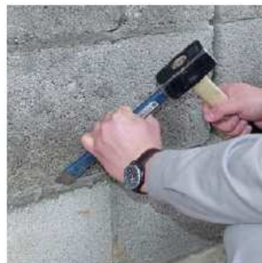
2. Malta vystupující ze spár a jiné ostré výstupky se musí odsekát. Vytékající cementové mléko je možné obrousit úhlovou bruskou.
