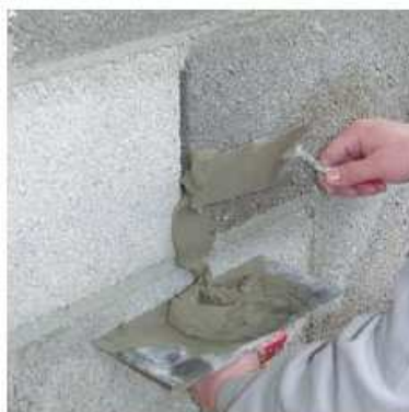
3. Nevyplněné spáry ve zdivu a všechny prohlubně hlubší než 5 mm se musí vyplnit se Sopro AusgleichsMörtel nebo se Sopro SchnellSpachtel.
