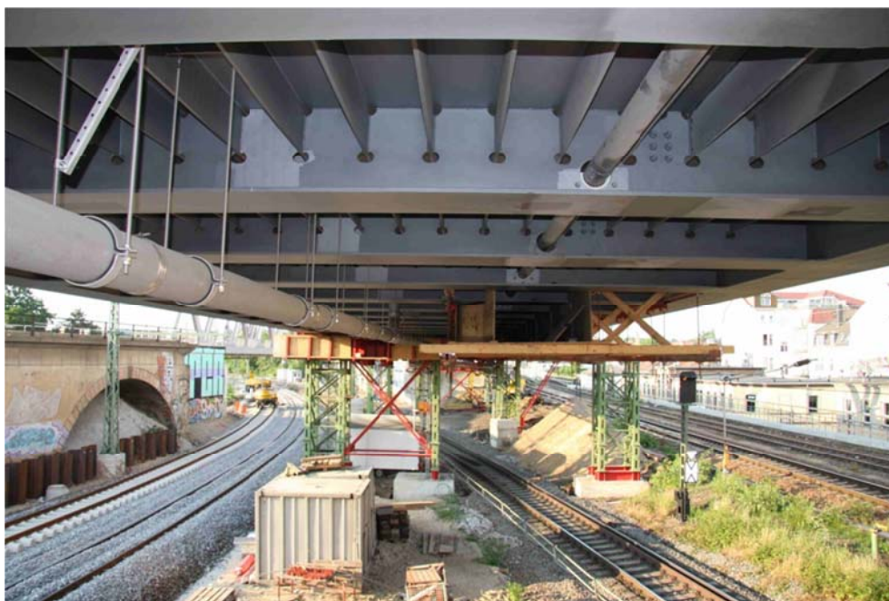
Obr. 5 Řídicí tyč na mostu v Drážďanech, řídicí prut vedoucí skrz příčnice
