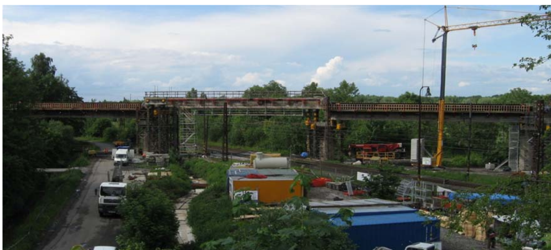
Obr. 2 Celkový pohled na stavenišť v průběhu výstavby
