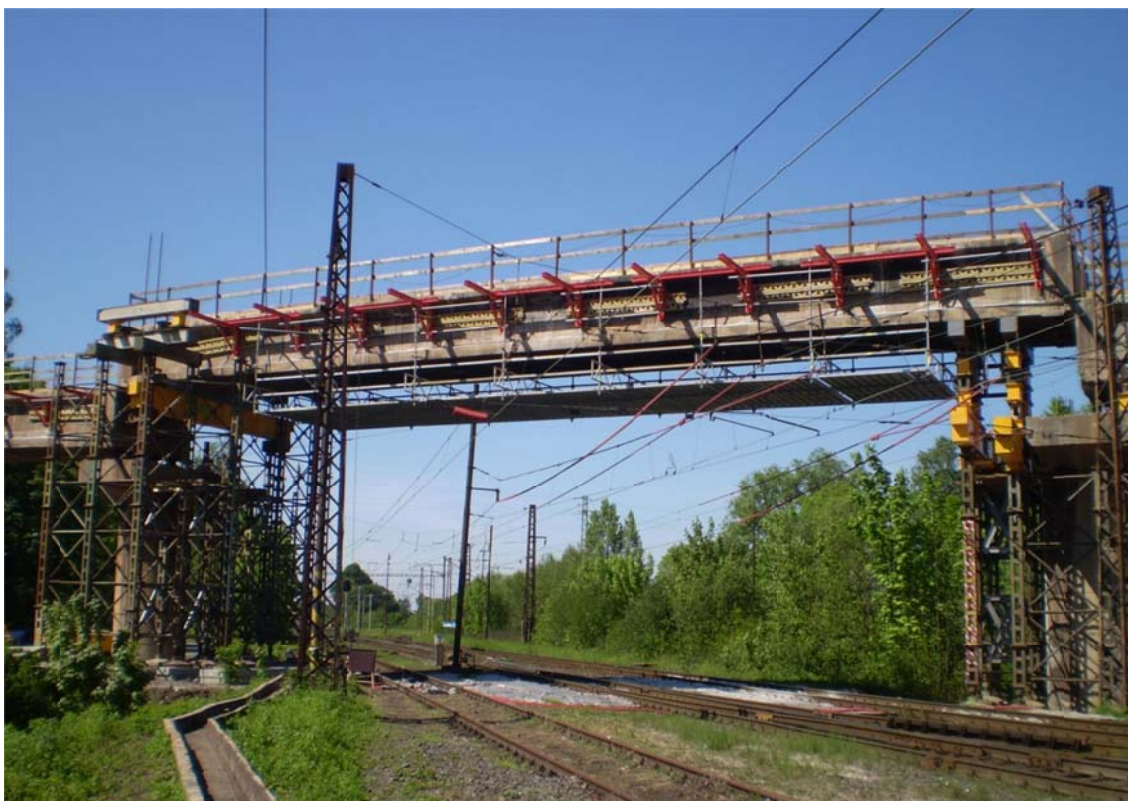
Obr. 3 Fáze zvednutí pole nosné konstrukce nad tratí Český Těšín – Dětmovice
