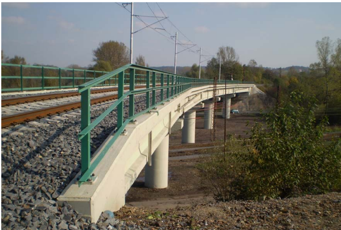
Obr. 1 most po rekonstrukci
