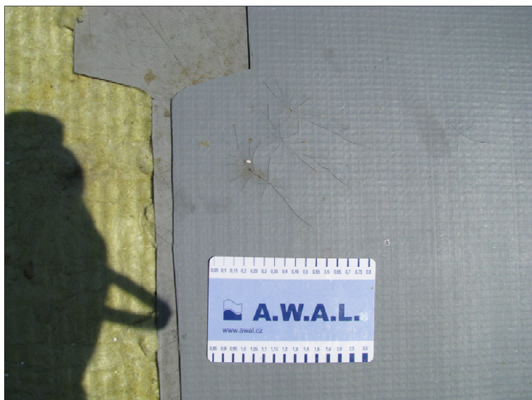
Obr. č. 4 – Vícenásobně popraskaná fólie PVC
