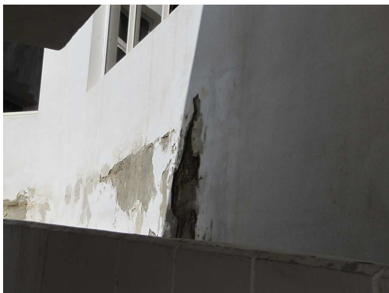
Obr. č. 1 - Vlhkostní porucha v interiéru
