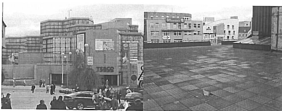
Obrázek č.3 - Demontovaný plášť OD Tesco včetně detailu stavu terasy
