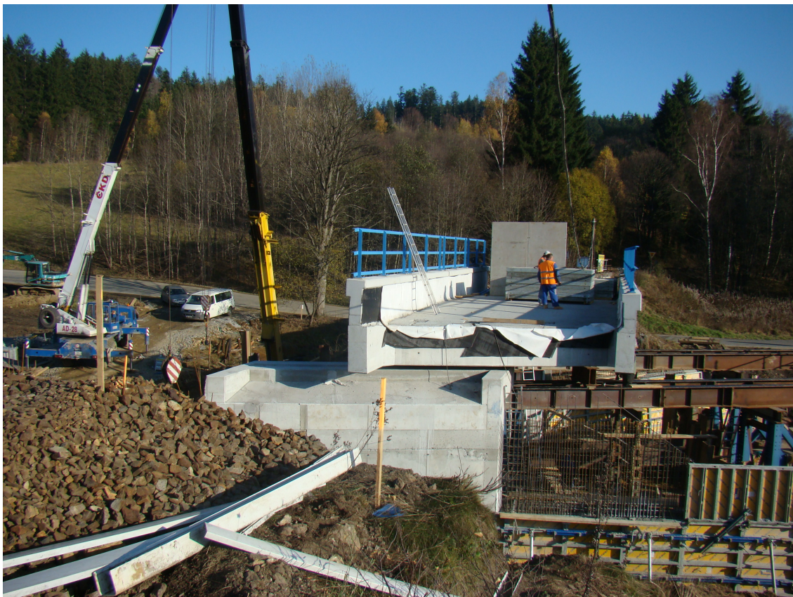
Obr. 3 Probíhající příčný zásun mostu
