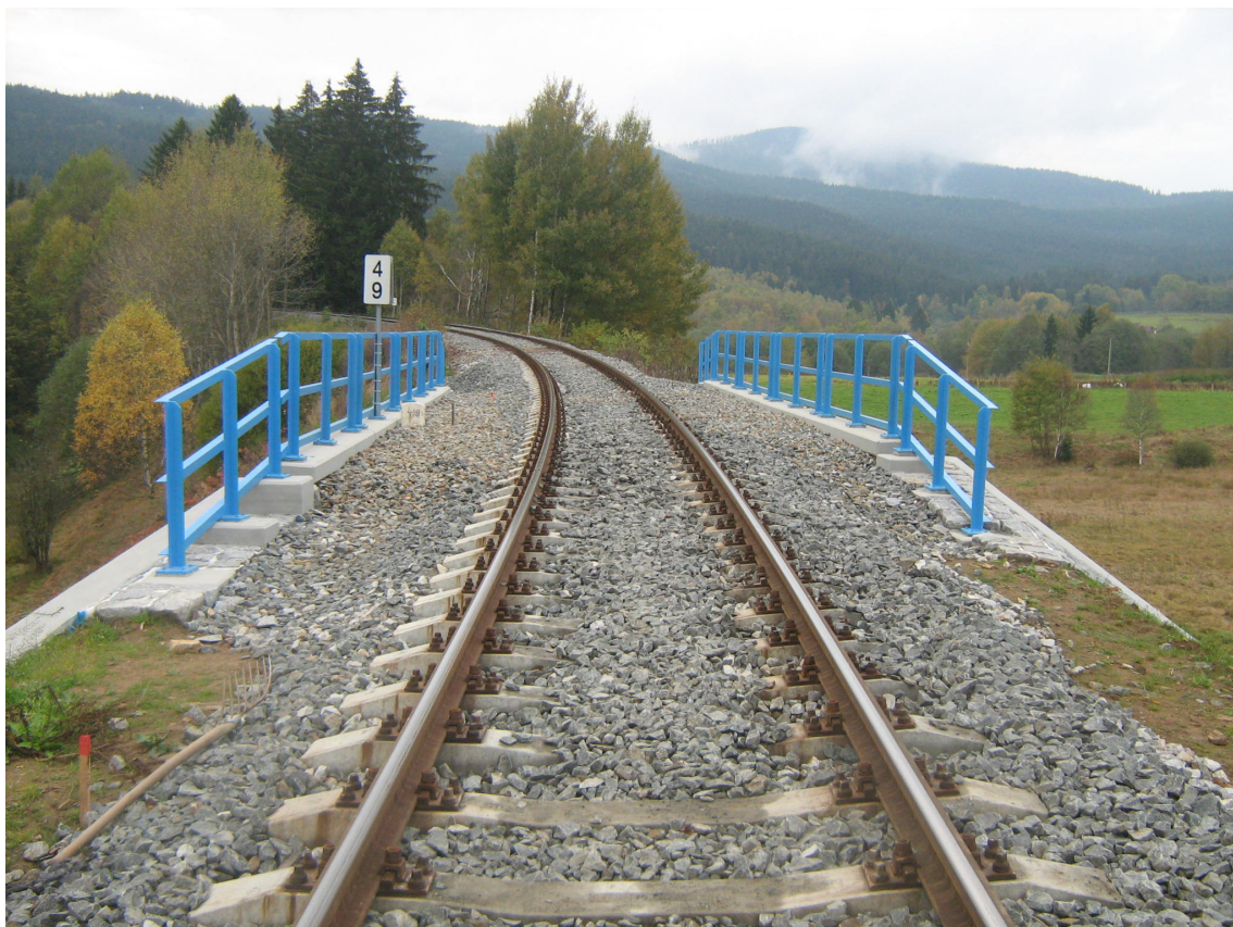
Obr. 4 Pohled na nová kolejová pole ze směru od Plzně
