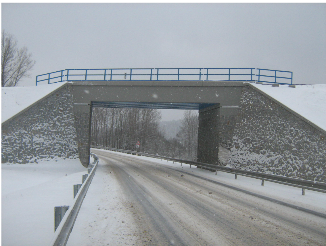
Obr.1 Pohled na most ze směru od Špičáku
