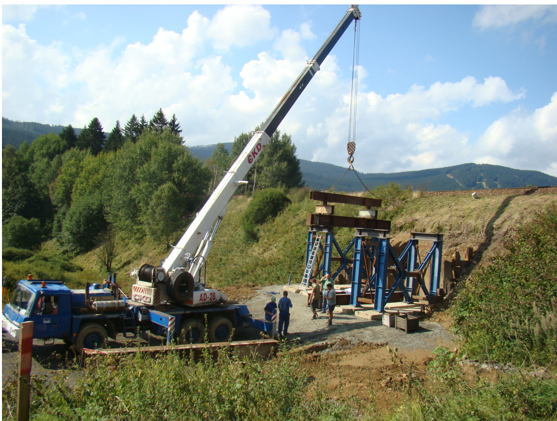
Obr.2 Montáž podpěrných věží pro betonáž a následný zásun NK
